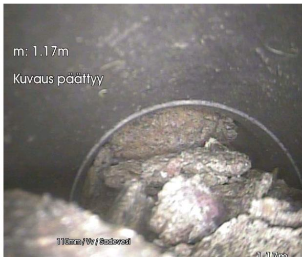
Kuva 7.7 Sadeveden viemäriin jassa kiviä. (Kuvaus SVTK1).
