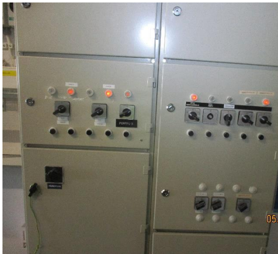
Kuva 8.21 IV-konehuoneissa myös käsikäyttökytkimet.
