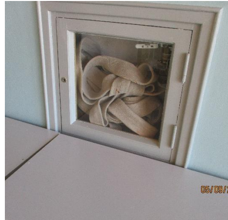
Kuva 6.17 Muutamia alkuperäisiä pikapalopostikaappeja yhä käytössä.
