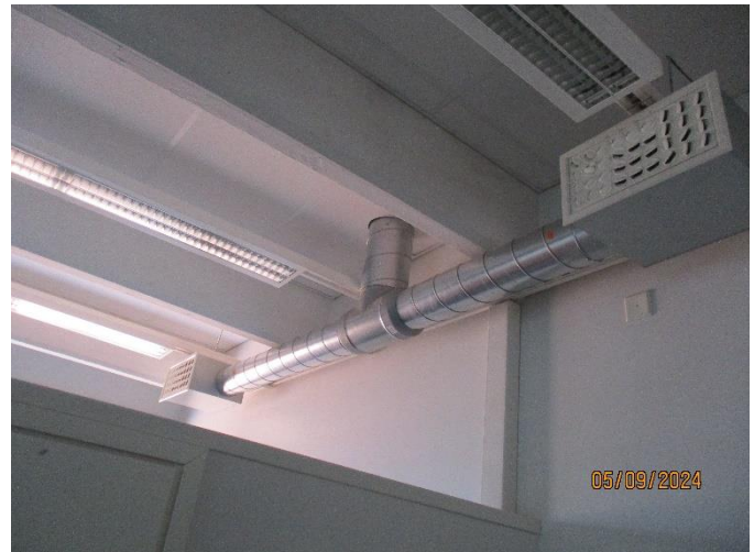
Kuva 8.14 Liitäntälaatikollinen tuloilmasäleikkö.
