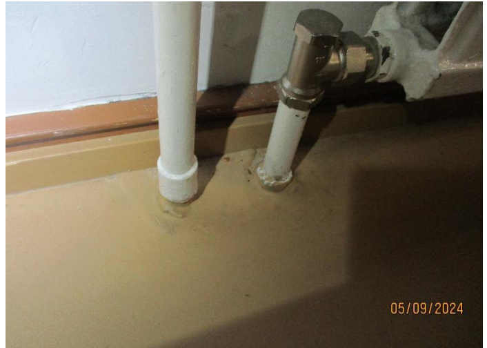
Kuva 5.8 lämpöjohtoputkien asennuksia, joissa putket ovat suojaholkkien sisässä kiviaineisessa materiaalissa.
