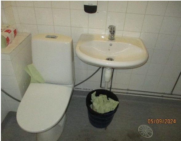
Kuva 6.12 Kellarin WC-tilan kalusteita. Hana Oras, WC-istuin ja allas Ido. Kalusteet uusittu peruskorjauksessa.
