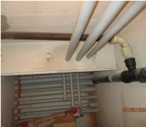
Kuva 6.10 A-osan lämmönjakohuoneessa keittiön valurautaista rasvaviemäröintiä.
