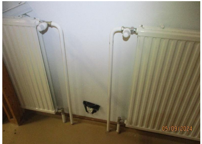
Kuva 5.14 Liikuntasalin teräslevypattereita.
