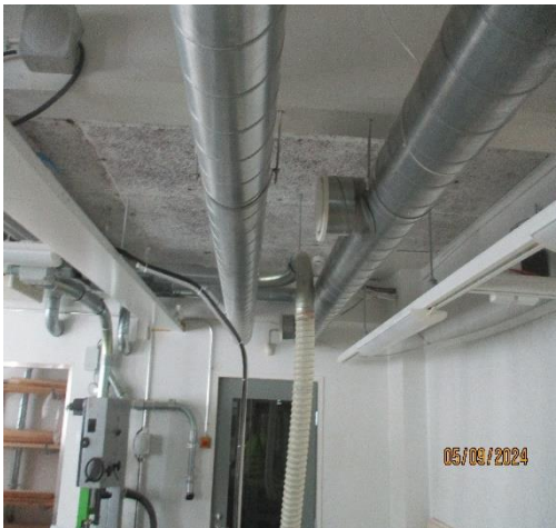
Kuva 8.13 Poistoilman säädettäviä kartioventtiileitä (KSO)
