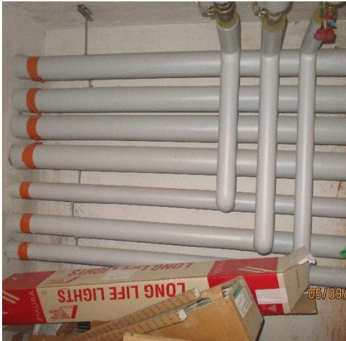
Kuva 5.7 Uusittuja putkiverkostoja teknisestä tilasta.
