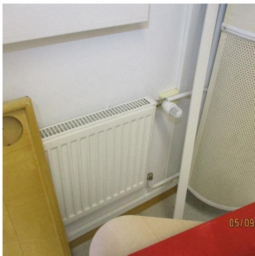
Kuva 5.13 1.kerroksen teräslevystä valmistettu jaepatteri. Patteri alkuperäisasennus, termostaatti-venttiili asennettu 1998.
