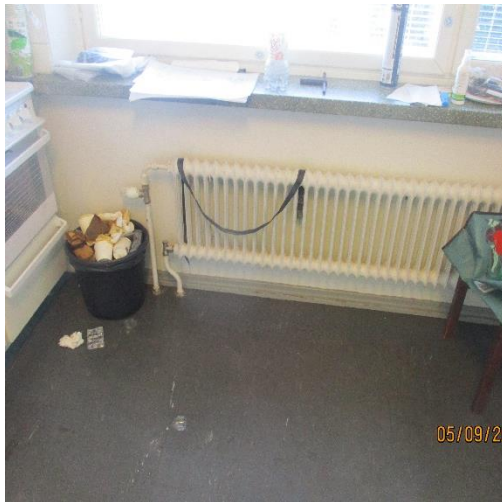
Kuva 5.13 1.kerroksen teräslevystä valmistettu jaepatteri. Patteri alkuperäisasennus, termostaatti-venttiili asennettu 1998.
