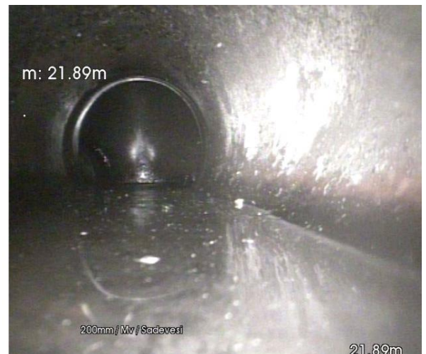
Kuva 7.8 Sadeveden viemäriin joissa paikallisia painumia. (Kuvaus SVK1).
