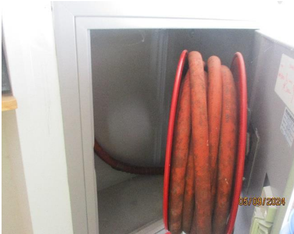
Kuva 6.16 Pikapaloposteilta ei löytynyt tarkastusmerkintöjä. Asennusvuosi 1997.
